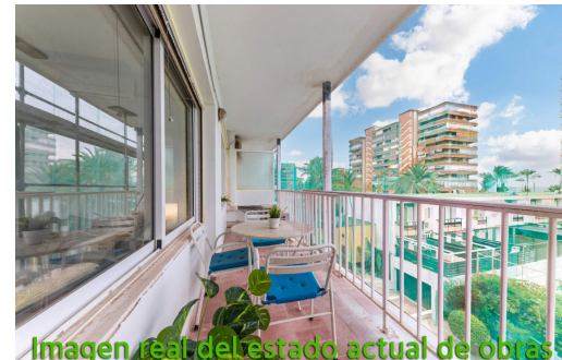
Imagen real del estado actual de obras
